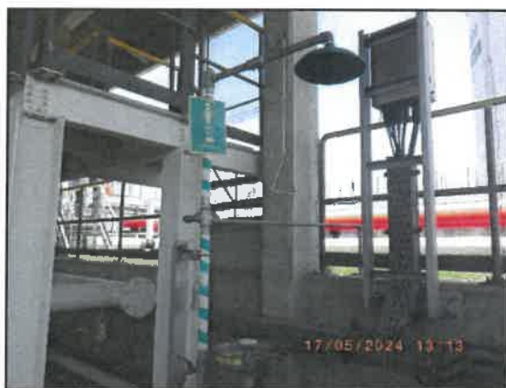
รูปที่ 2-20 อ่างล้างตาฉุกเฉิน
