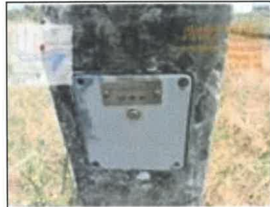
รูปที่ 2-10 (ต่อ) ตัวอย่างการบำรุงรักษาแท่งแมกนีเซียม (Cathodic Protection) ตลอดแนวท่อ
