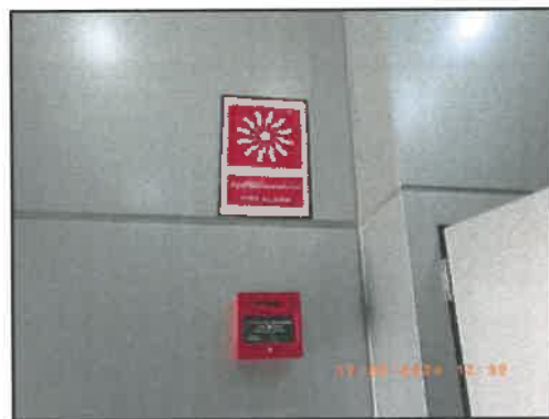
รูปที่ 2-18 ระบบตรวจสอบ ตรวจจับ และสัญญาณเตือนภัยแบบอัตโนมัติ
